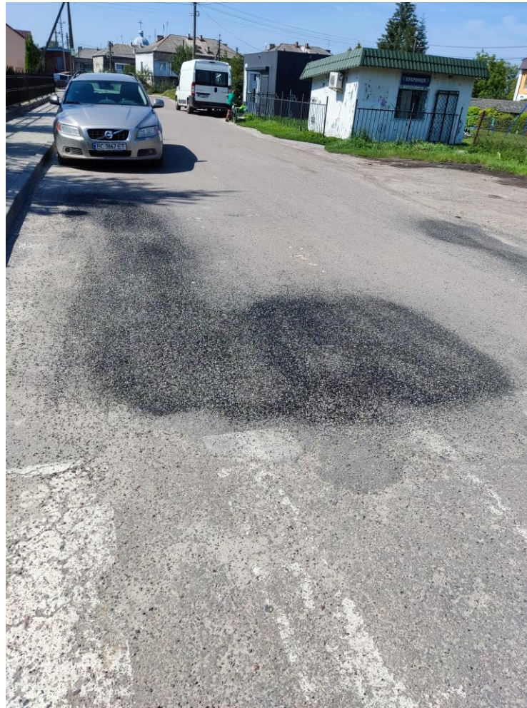
Поточний ремонт вул.Чорновола, м.Городок
