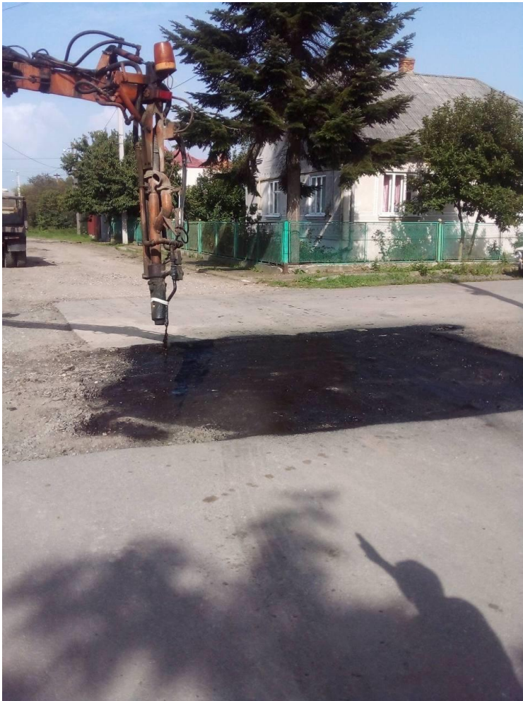
Поточний ремонт вул.Вишеньського, м.Городок
