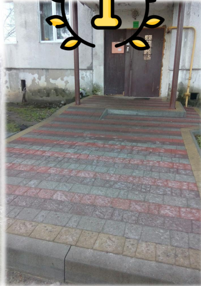
Облаштування та благоустрій площадок біля під'їздів будинку по вул.Авіаційна, 111
