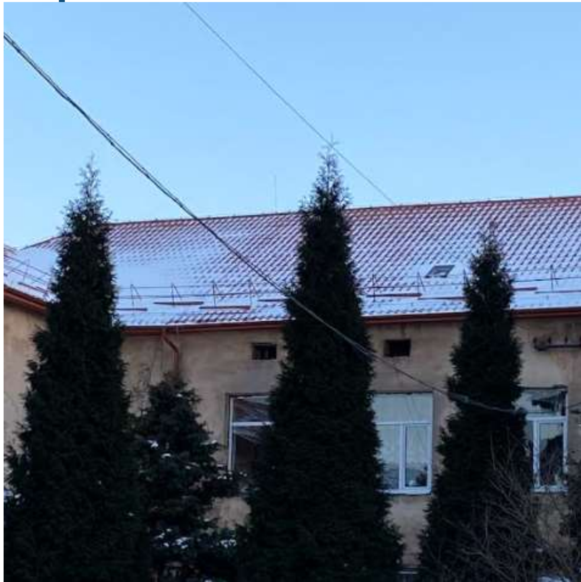
Проведено капітальний ремонт даху будівлі поліклініки
