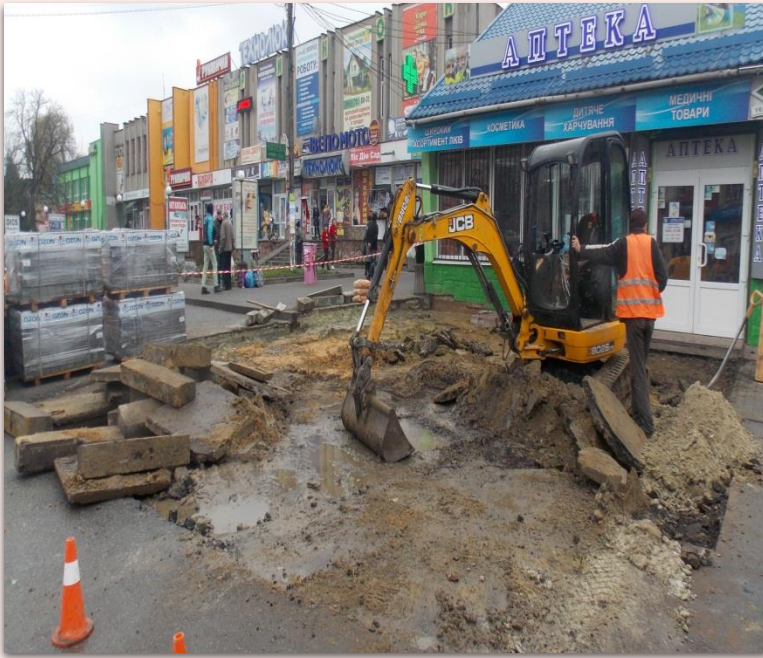
Поточний ремонт площі вул.Перемишльська
