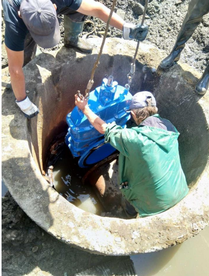
Засувка фланцева Ø500мм — 90 000,00 грн — встановлено на КНС вул.Коновальця
